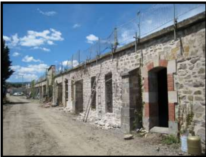
Percement des ouvertures sur les locaux collectifs
