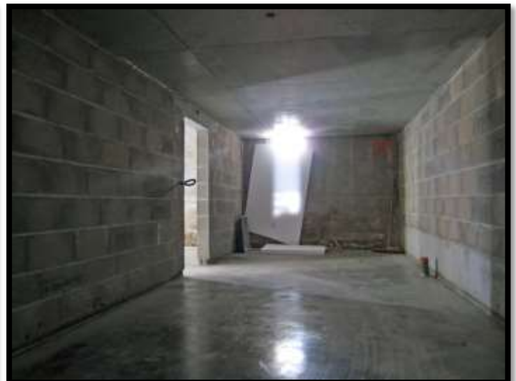
Local peinture et rangement vu de l'extérieur et de l'intérieur. La dalle surfacée au quartz à été coulée.
