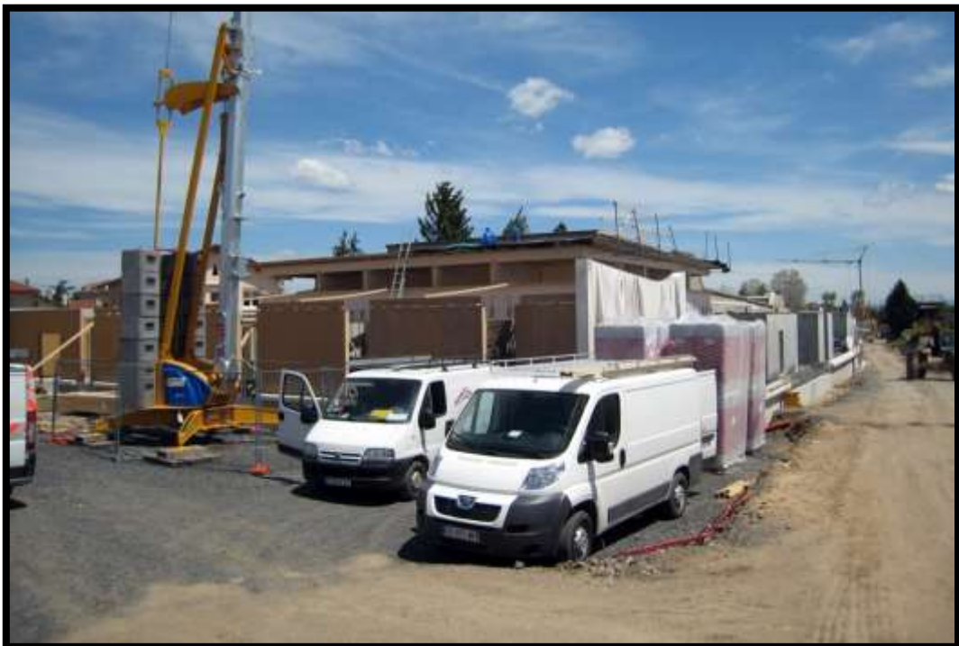
Les camionnettes commencent à envahir le chantier
