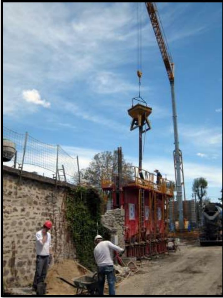
Coulage de murs béton.
