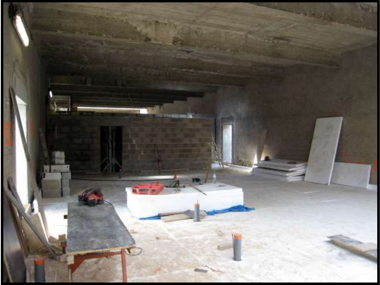
Activité intense dans le local avec la mise en place de l'isolation de sol et passage de réseaux divers
