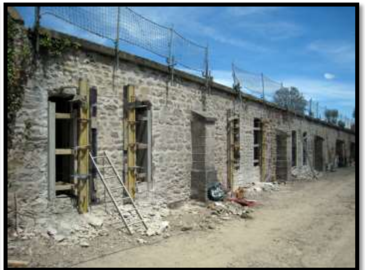
Percement des ouvertures sur les locaux collectifs
