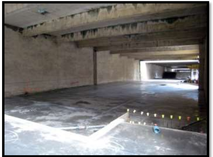
Mezzanine dans les salles de sports Premiers coulage de dalles en béton
