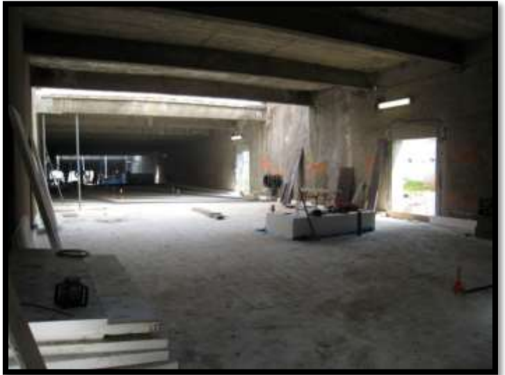
Vue intérieur du local
