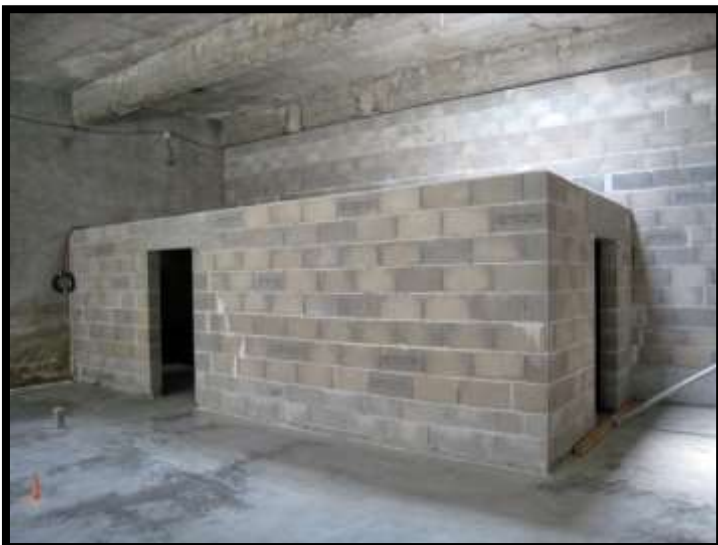
Local peinture et rangement vu de l'extérieur et de l'intérieur. La dalle surfacée au quartz à été coulée.
