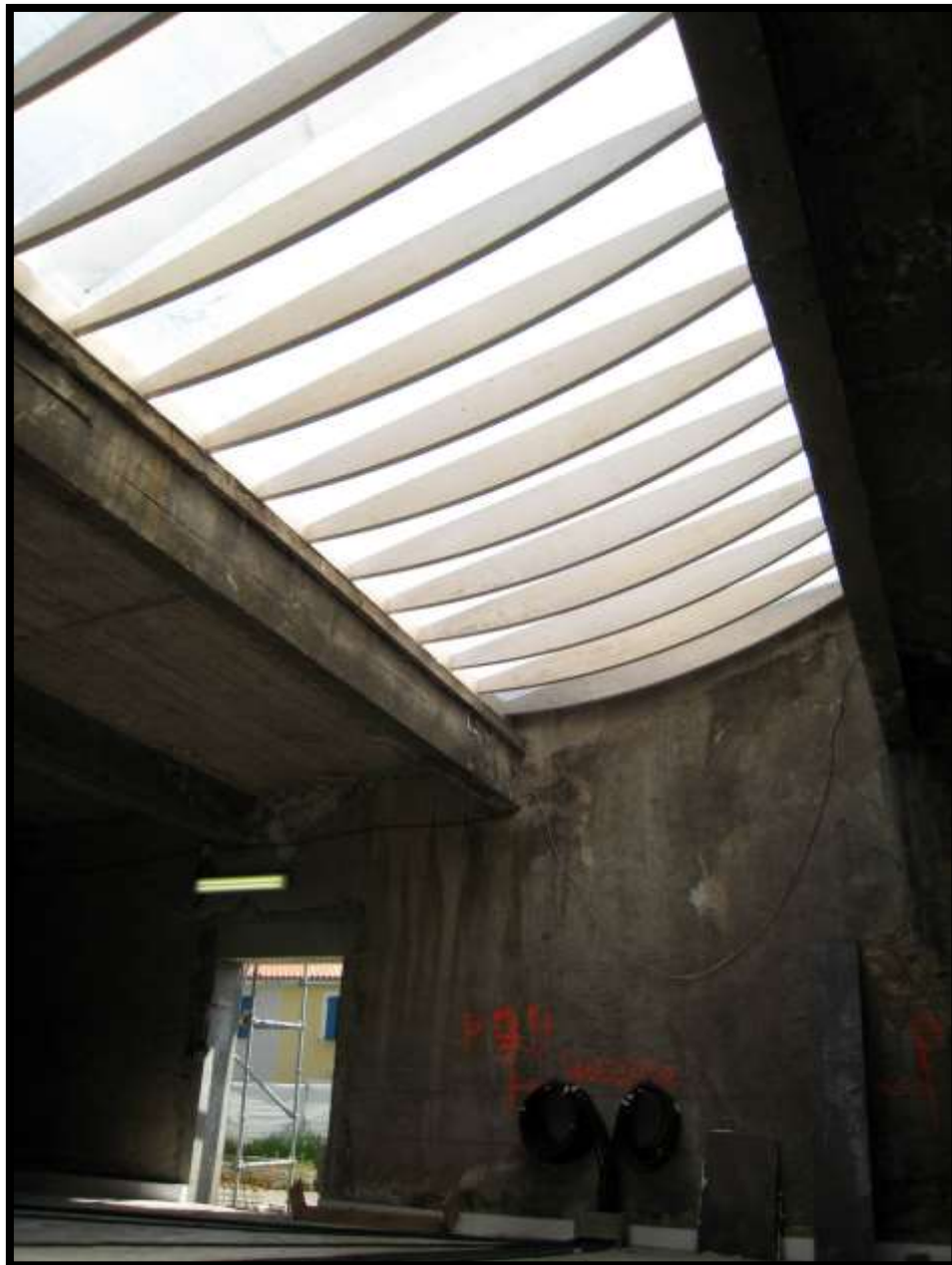
La charpente bois incurvée de la verrière est en place
