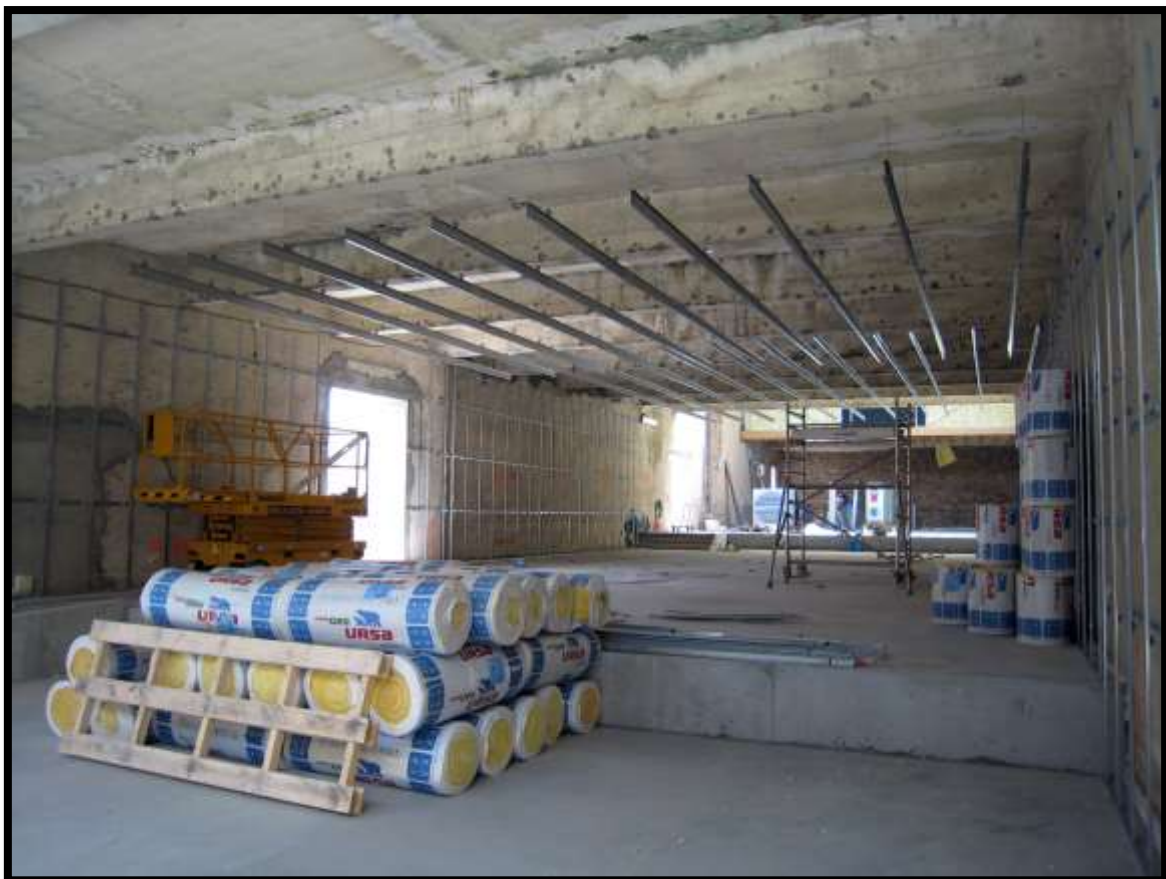
Premier travaux de doublage des murs et plafonds dans les salles de sports.
