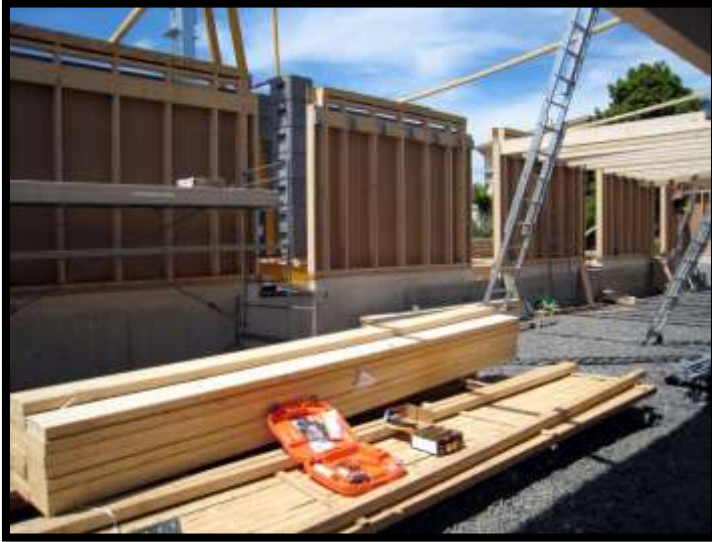
Construction des murs en bois extérieurs des salles de sports
