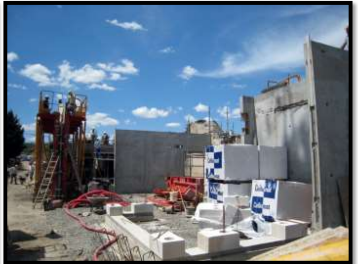
Construction des bâtiments collectifs
