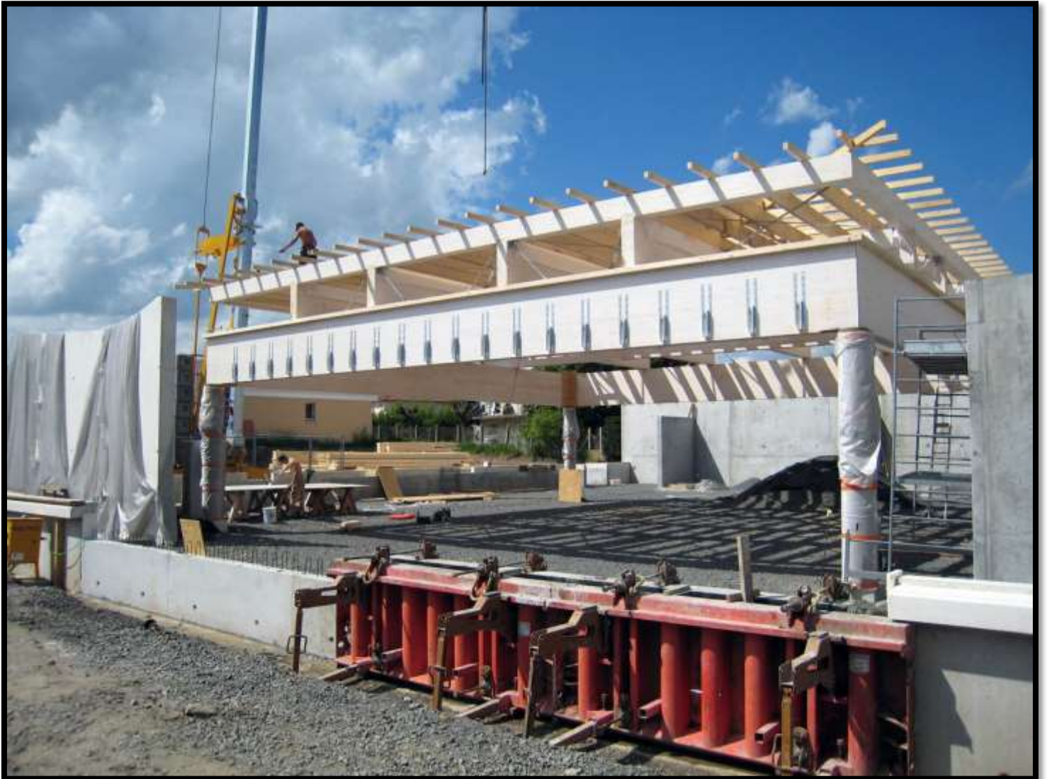
Début de pose de la charpente des bâtiments annexes
