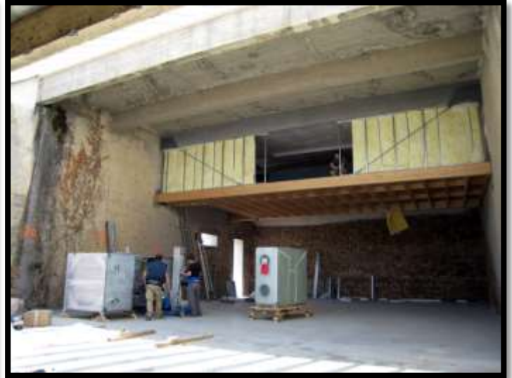
Mise en place des premiers groupes ventilation.
