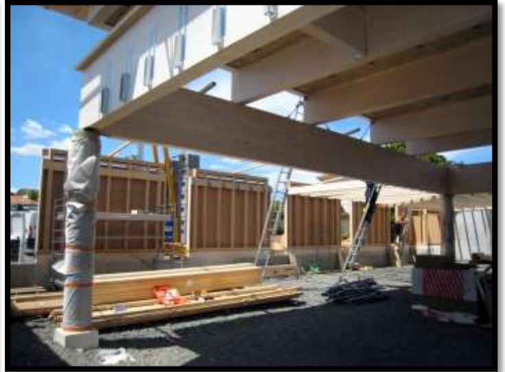
Construction des murs en bois extérieurs des salles de sports
