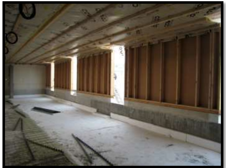
Montage des parements bois sur les façades et isolation des plafonds.
