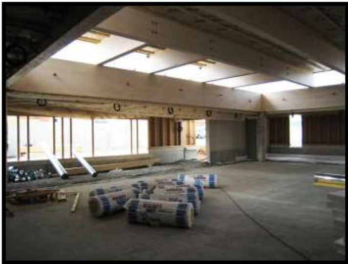
Montage des parements bois sur les façades et isolation des plafonds.
