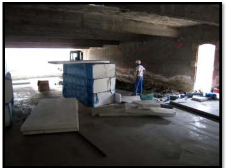
Montage des parements bois sur les façades et isolation des plafonds.
