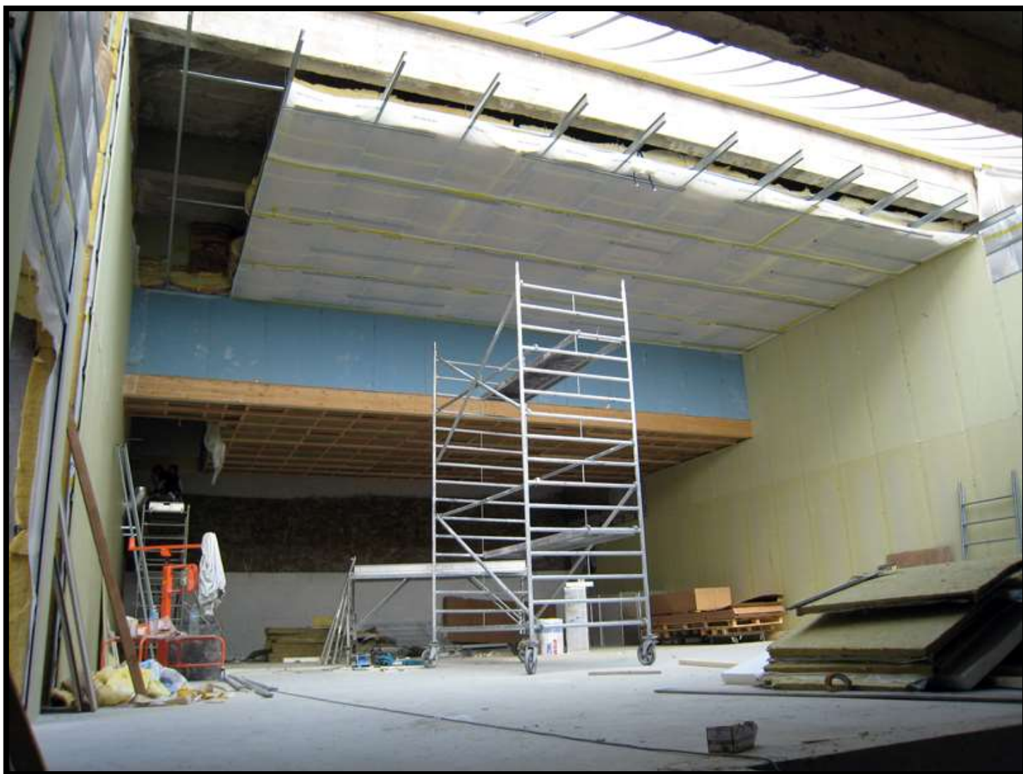
Isolation des murs et des plafonds dans les salles de sports.
