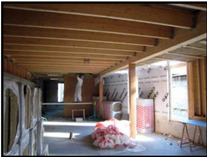
L'ossature bois reçoit l'isolation thermique.
