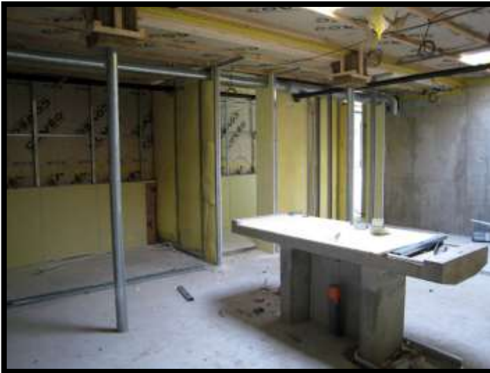
Passage des gaines électrique et de ventilation.
