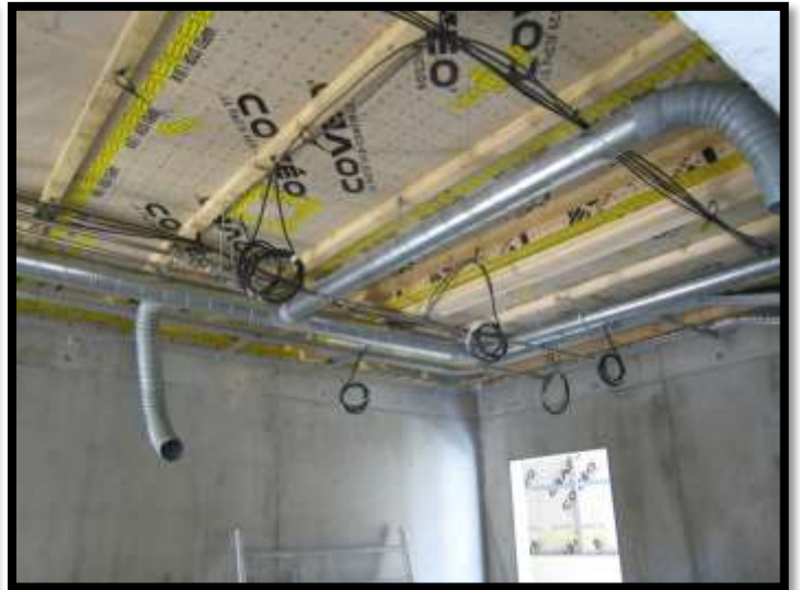
Passage des gaines électrique et de ventilation.
