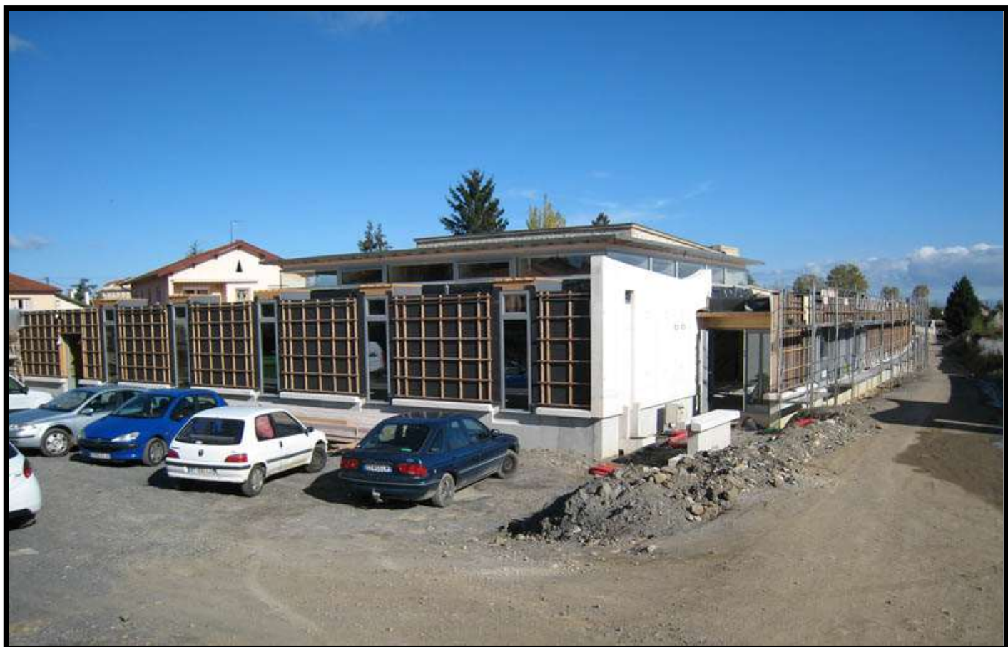
Le bâtiment commence à prendre sa forme définitive.
