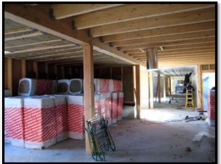
L'ossature bois reçoit l'isolation thermique.
