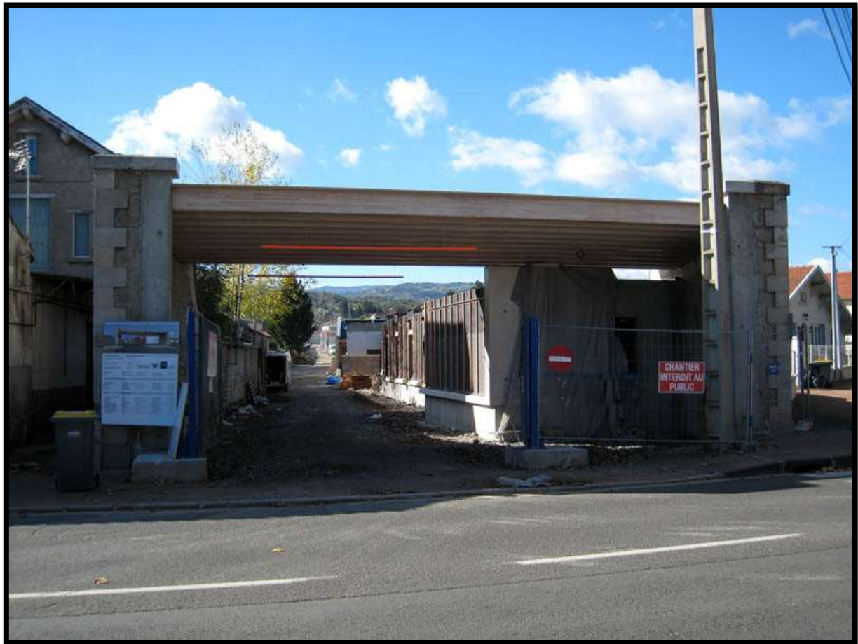
L'entrée principale côté Avenue Thermale à reçue sa couverture bois.
